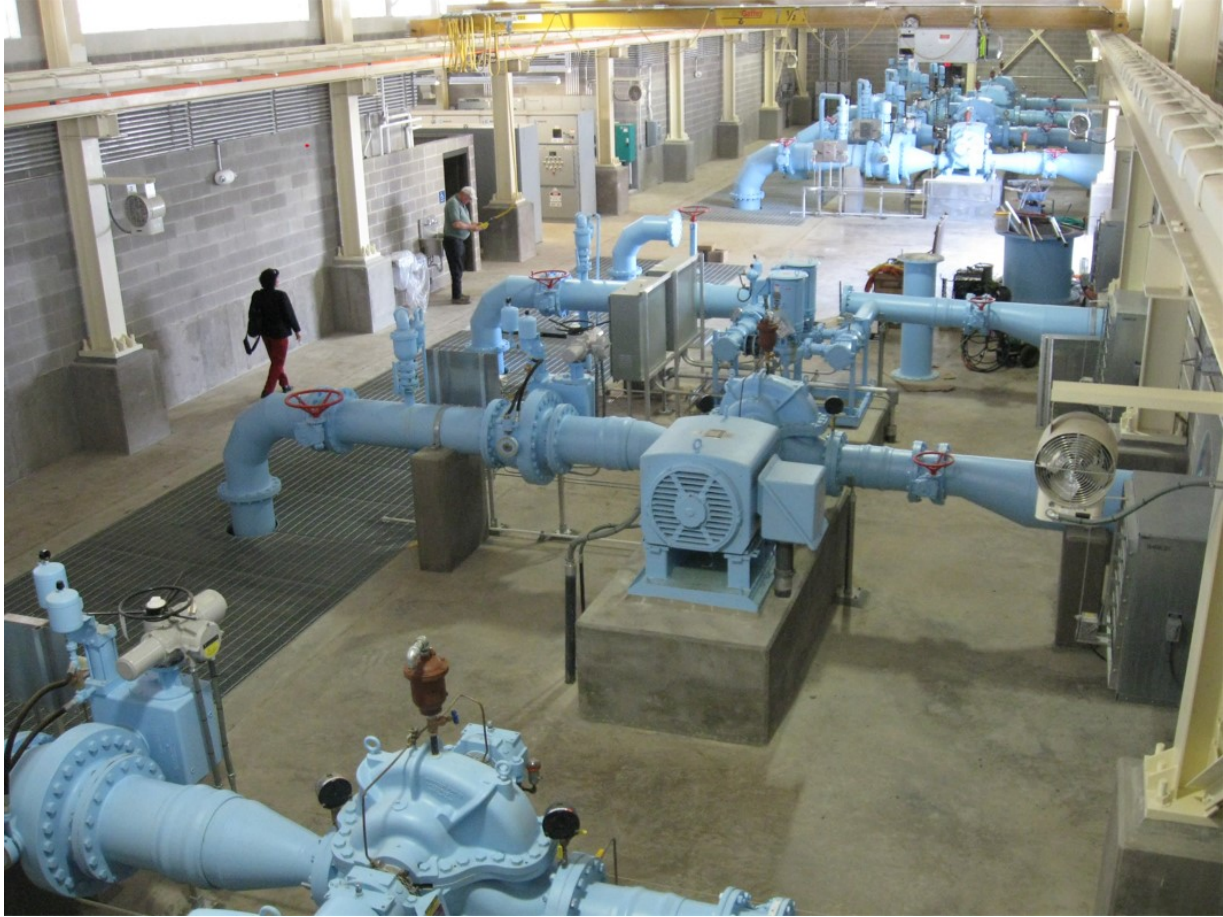
Estación de Bombeo Sendera Ranch
