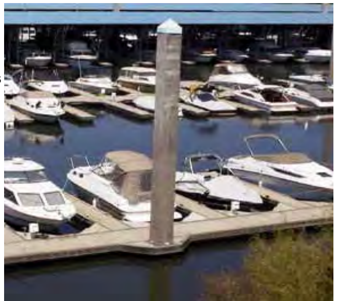
8.11.4.E: Concrete guide pile
