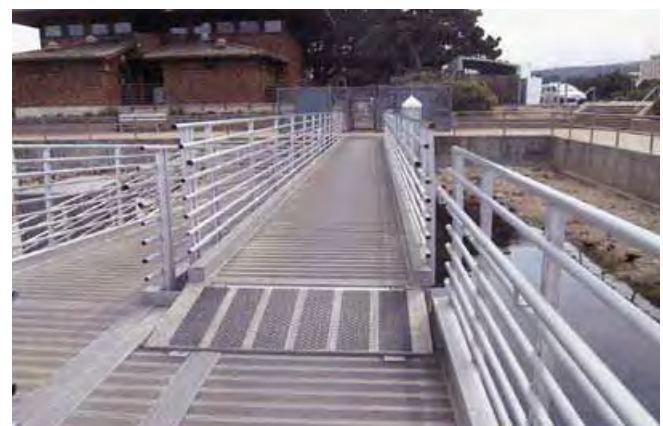
8.11.4.H2e: Gangway railing
