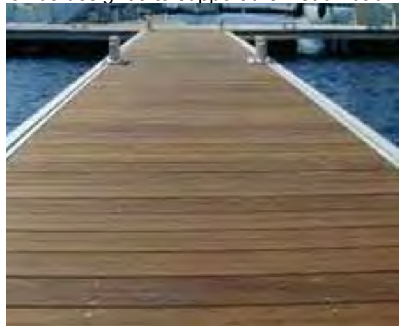
8.11.3.E4: Wood decking
