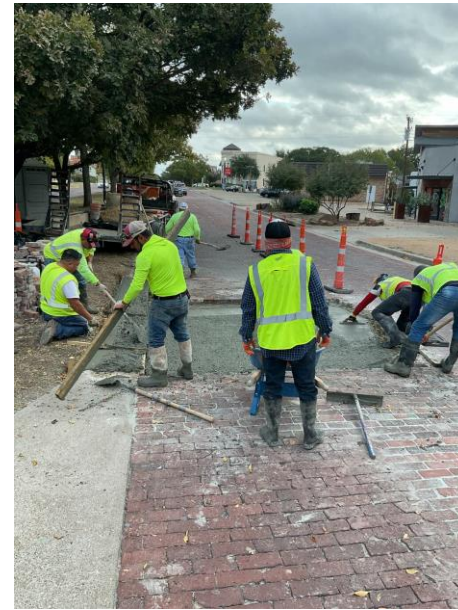
4. Pour new concrete
