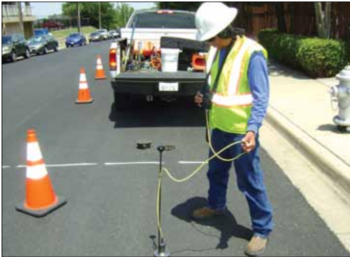
Un empleado capacitado usa equipo especial para escuchar fugas en las líneas de agua subterráneas.
